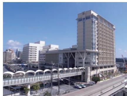
モノレール旭橋駅周辺
