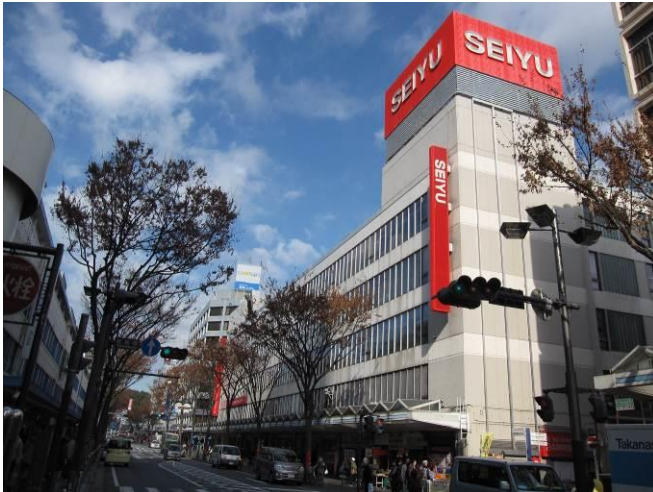
【再整備前の状況】
